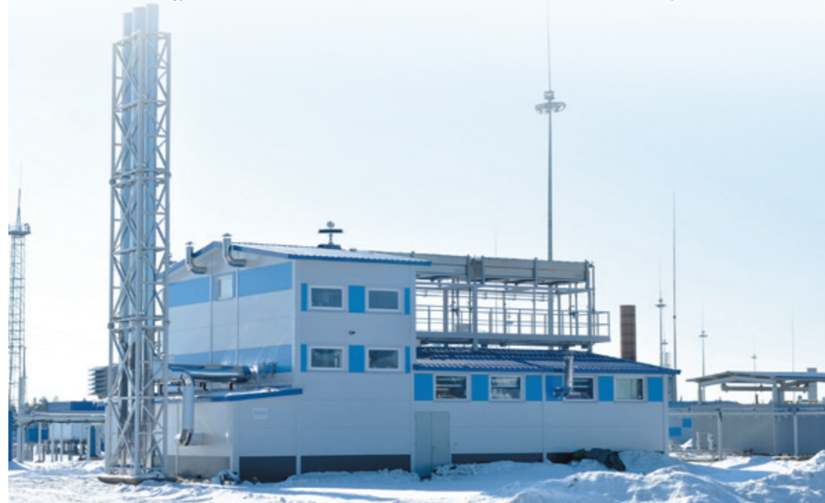
Рис. 1. Комплекс термического обезвреживания КТО-1000.БМ.КСЖ (КС Портовая)
